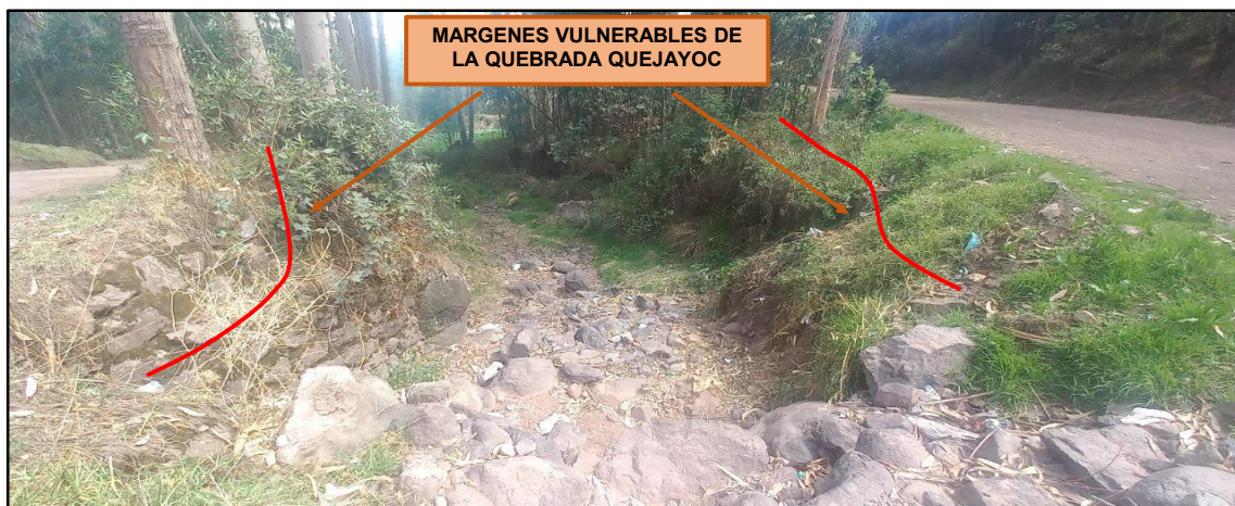
FOTOGRAFIA N°02: SE VISUALIZA EN TODO EL TRAMO MATERIAL COLMATADO Y PRESENCIA DE EROSIÓN ACTIVA EN LAS MARGENES DE LA QUEBRADA QUEJAYOC.
